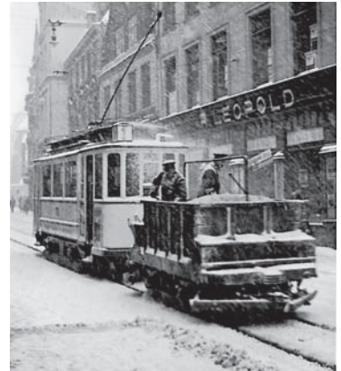
Winterinsatz in der Holstenstraße in Richtung Markt zwischen Faulstraße und Nikolaikirche in den 1930er Jahren. Mit Ledermantel und hochgeschlagenem Kragen schaufelten die Männer im Schneetreiben das Salz in die Trichter. Zur Eiseskälte fiel ihnen zusätzlich der ganze Schnee vom Dach des Motorwagens ins Genick. Heute unvorstellbare Arbeitsbedingungen. (Slg. Jörg Classen)
