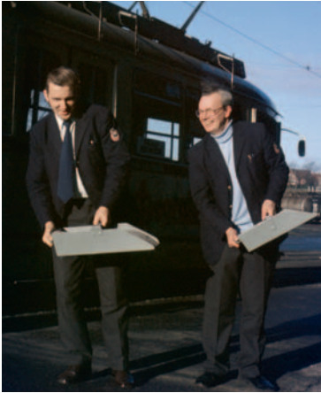
Auch das gehörte zur Arbeit eines Straßenbahnfahrers: das Nachfüllen der Sandkästen mit feinem Brems sand wie hier an der Endhaltestelle „Fähre Holtenau“.
